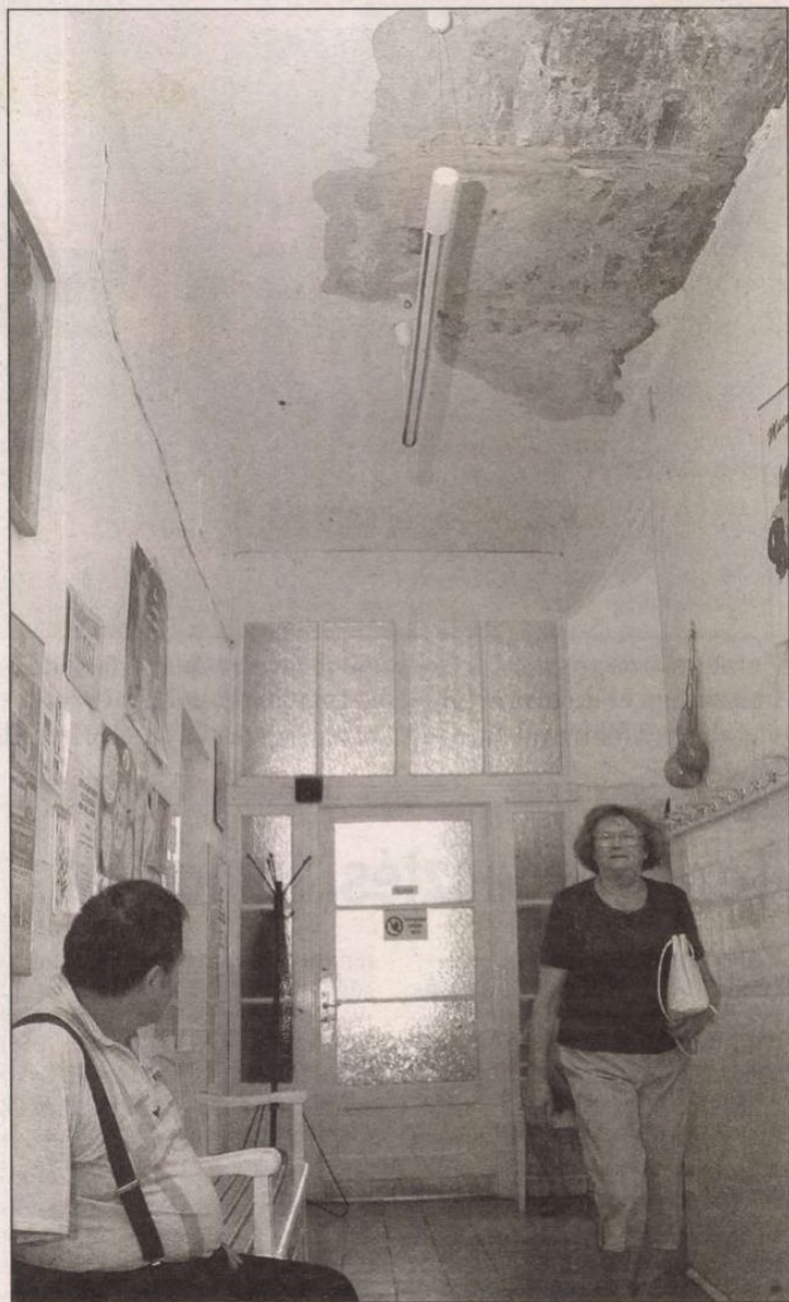
A nagykanizsai kórház rekonstrukciójára szánt 1,4 milliárd forintból az „E” épület teljes felújítása is megvalósul Fotó: Sz. A.
