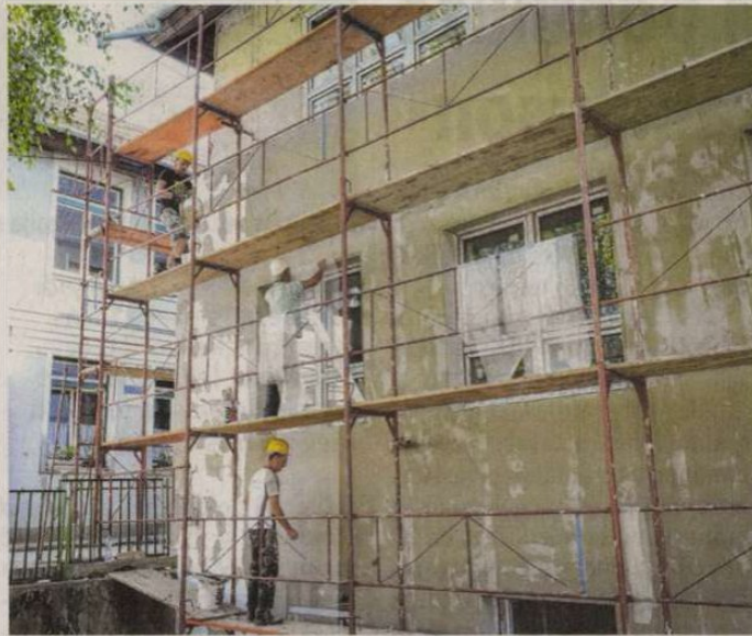
A kivitelező munkatársai szigetelik az épületet FOTÓ: SZAKONY ATTILA
