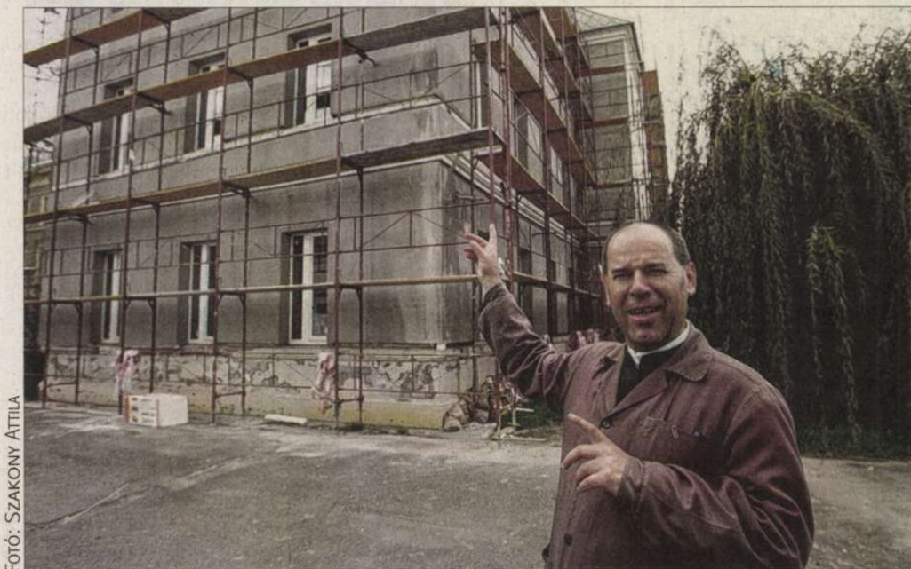
Nyeste Pál igazgató a felállványozott alsós épület előtt. A falak 10 centiméteres szigetelést kaptak
