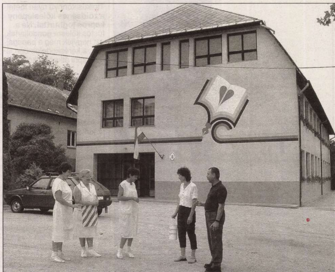
Tanterembővítésre vár a zalaszentbalázi általános iskola épülete is
